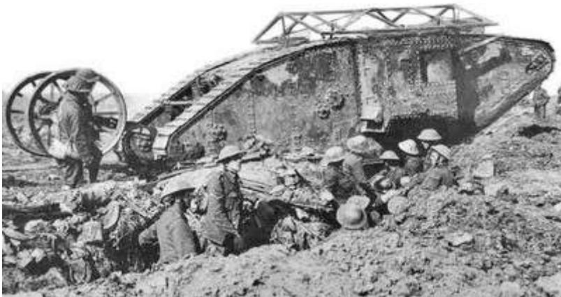
Tank MK1 (Mark 1) : à l'arrière le système permettant de rallonger artificiellement le char afin qu'il puisse franchir des tranchées plus larges
