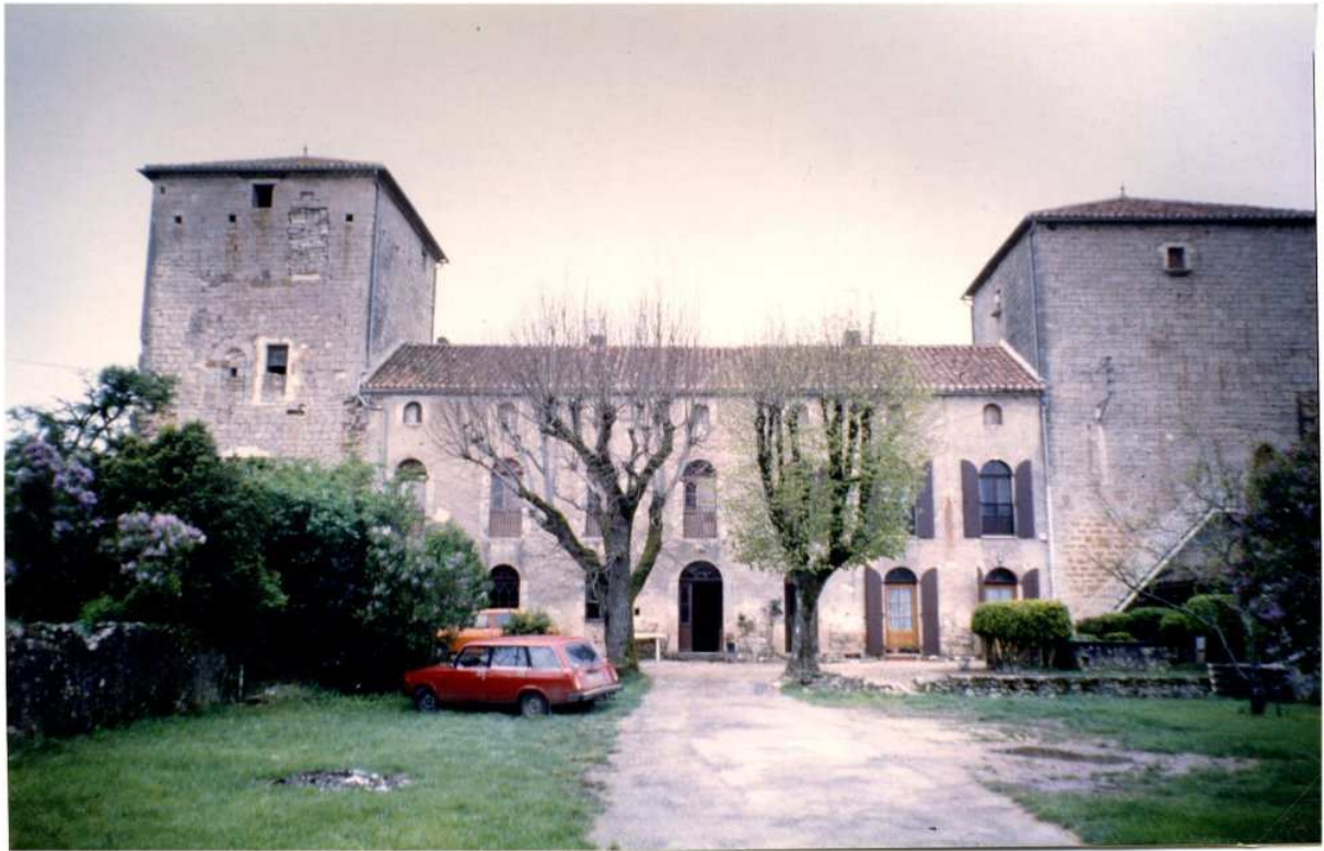
Le château en 1994 – avant travaux de réhabilitation
